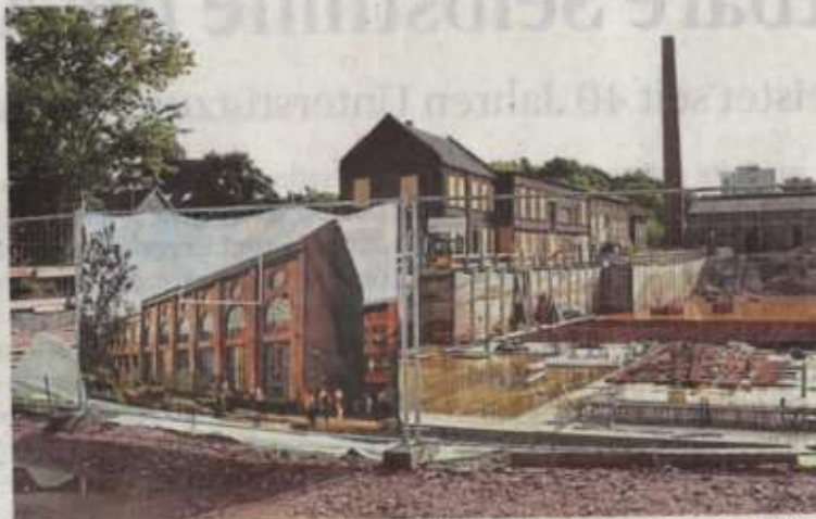
Wo 246 Wohnungen entstehen sollen, ruht die Baustelle seit Wochen. Foto: Uwe Schäfer
